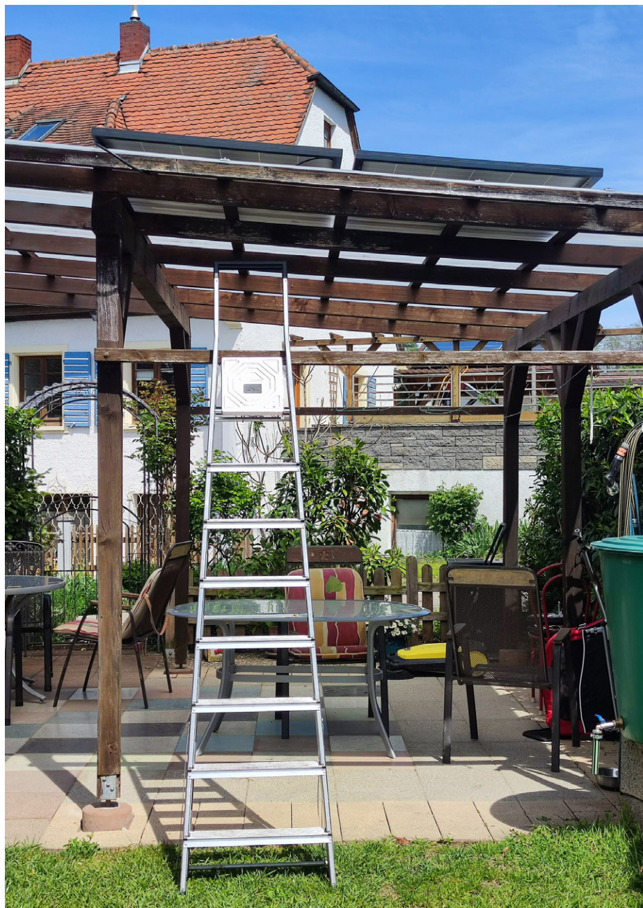
Figuur 10: Helemaal klaar, de zonnepanelen passen in het geheel en vallen niet erg op.
