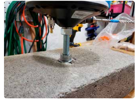
Figuur 6. Antennevoet vastgezet op de keilbout.
