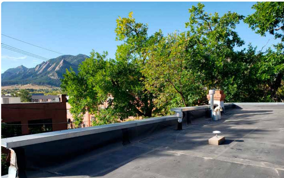
Figuur 7. L1/L2 antenne semi-stationair op een plat dak. Het is een gezwoeg om een 16kg-betonsteen naar het dak te zeulen, maar dan heb je ook wat!
