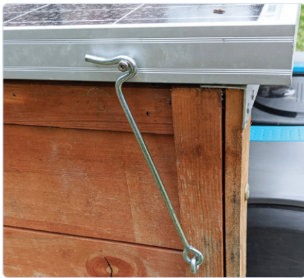
Figuur 7. Hoe het paneel windvast te maken.
